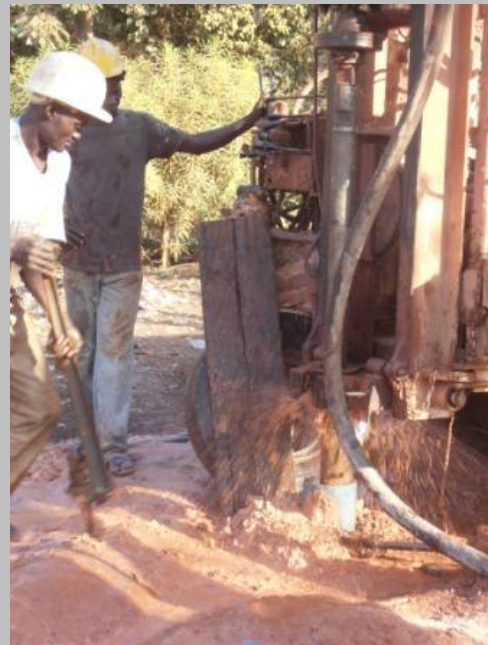
Construction du forage
